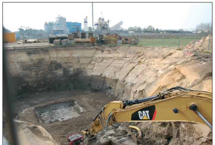
Zur weiteren Erschließung des Gewerbegebietes TE 7 werden gegenwärtig zwei Löschwassertanks auf diesem Gebiet errichtet. Bagger sind zurzeit dabei, den Erdaushub zu bewältigen, anschließend wird eine Verschalung aus Metall errichtet, die dann mit Beton vergossen wird. Anschließend werden die Tanks erdgleich dicht gemacht.
