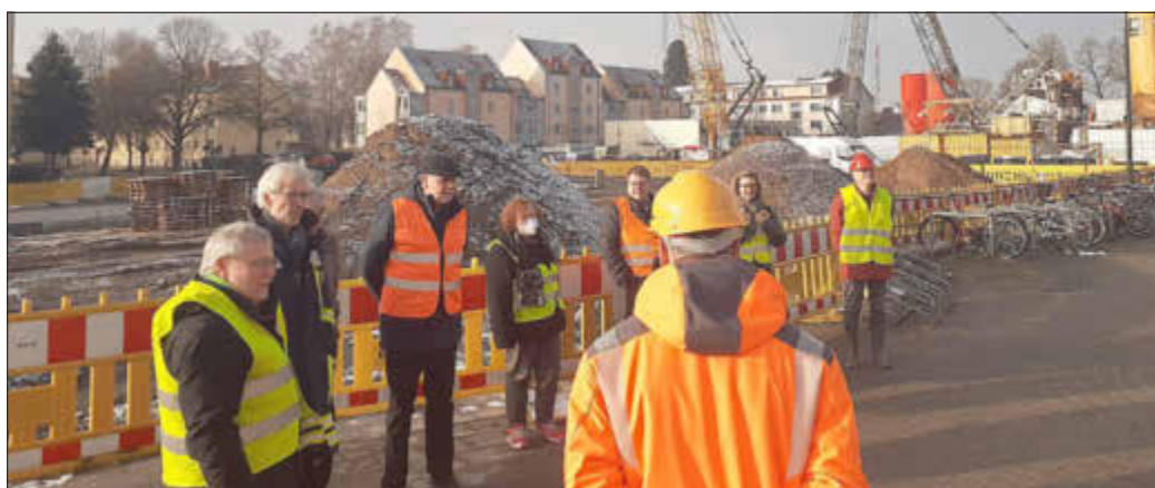
Gemeinsam wird die Tunnelbaustelle besichtigt.
