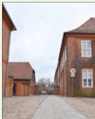
Für die Pflasterung wurde das gleiche Granitgroßpflaster gewählt, wie bei den barrierearmen Querungen in der Schloßstraße
