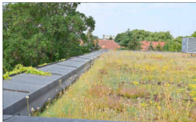
Für die Öffentlichkeit nicht sichtbar - die Dachbegrünung des Kaufhauses Fotos: Sylvia Wegener
