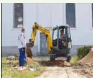
Neue Gas- und Stromleitungen am Kirchenplatz Foto: S. Wegener
