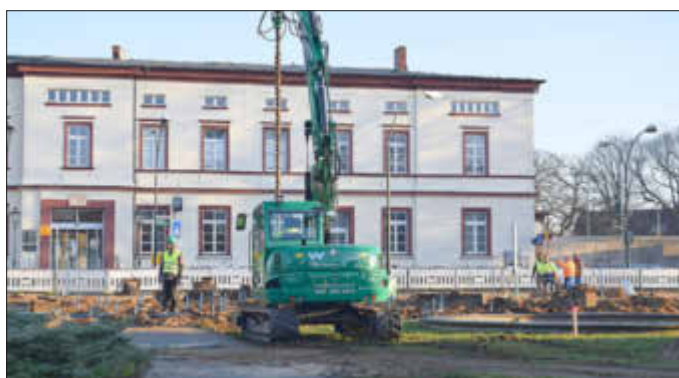
Die Suchschachtungen am Bahnhof laufen planmäßig Foto: Sylvia Wegener
