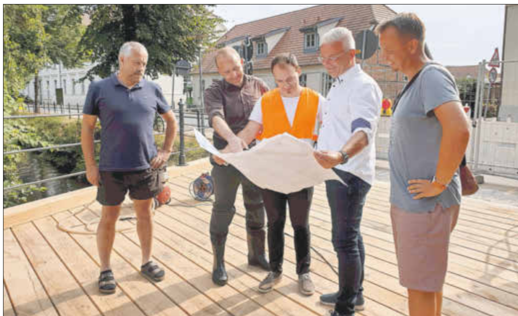
Vor-Ort-Termin zur Bauabnahme: Holger Rook von der bauausführenden Firma, Daniel Niemann und Timm Schmeling vom Planungsbüro WK-consult, Marco Leverenz von der Stadtverwaltung und Roman Sander von der Unteren Wasserbehörde des Landkreises Ludwigslust-Parchim
