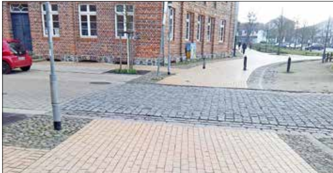
Der aktuelle Zustand der Fahrbahnquerungen in der Lindenstraße und der Schweriner Straße, die nun barrierefrei werden sollen
