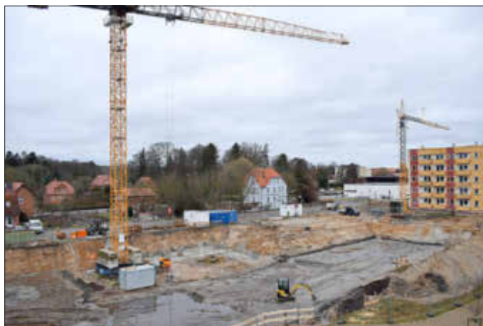
Eine riesige Baugrube und Kräne bestimmen das Bild im Parkviertel
