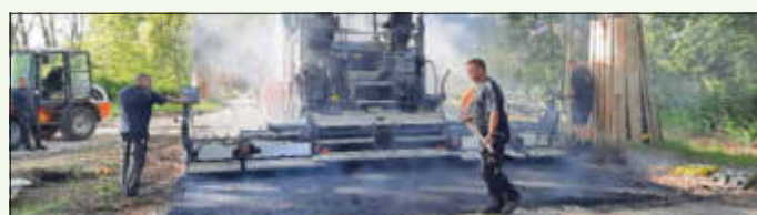
Schwere Technik kommt beim Asphalteinbau zum Einsatz
